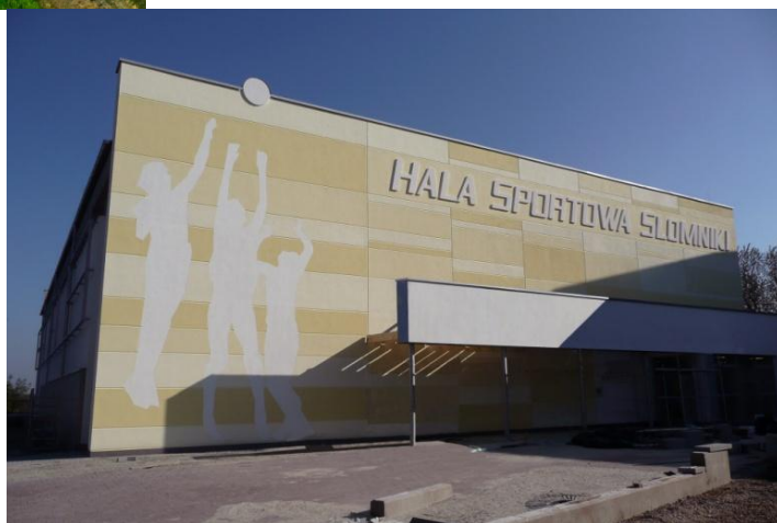
Rys. 27 Hala rekreacyjno-sportowa w Słomnikach (2)
