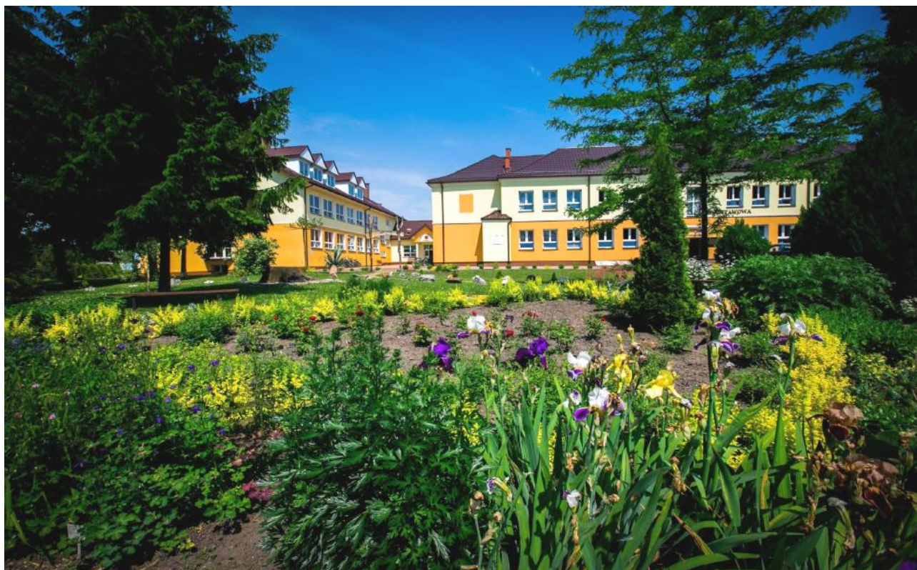
Rysunek 21. Budynki Zespołu Szkół w Mirczu po pracach termomodernizacyjnych i remontowych
