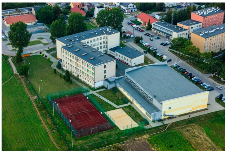
Rys. 26 Hala rekreacyjno-sportowa w Słomnikach (1)
